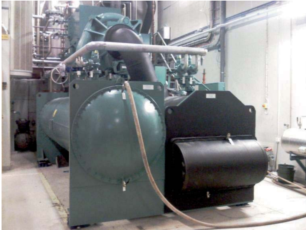
Figur 6 Vätskekylaggregatet, Kylmaskin 4
