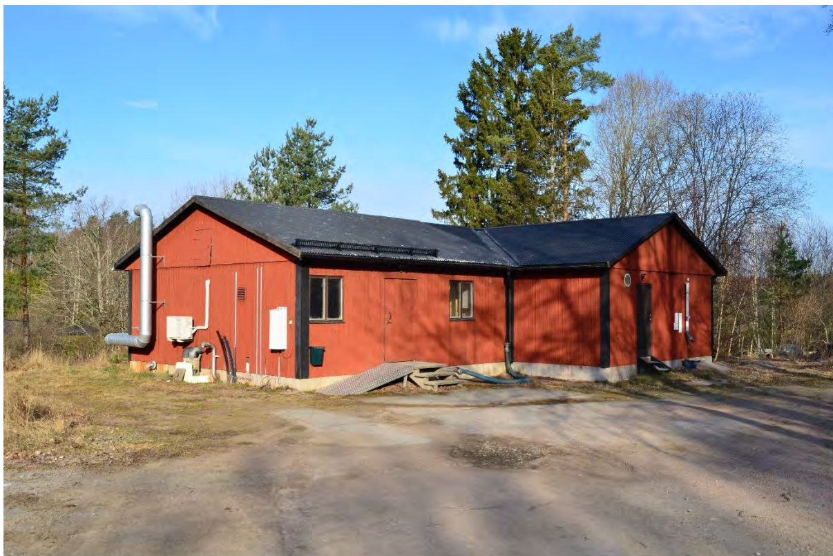
Figur 3. Flintavik reningsverk. Foto: Michael Kämpenber.
