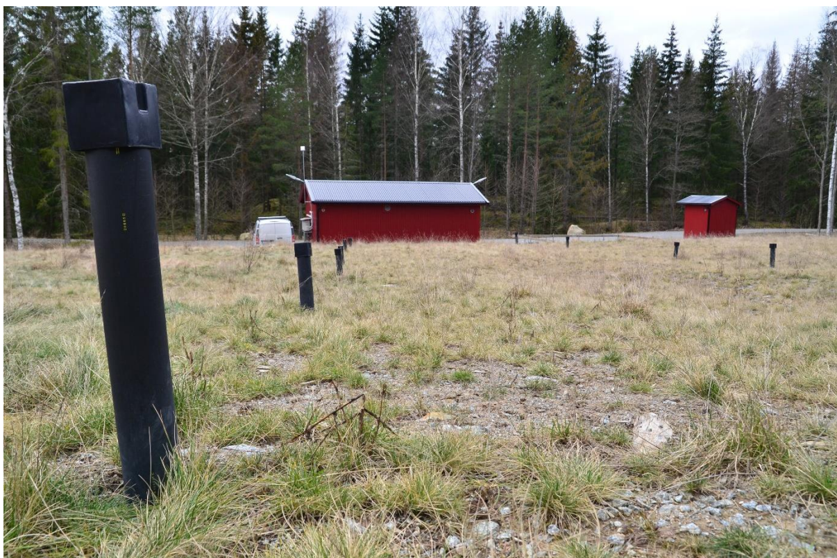
Figur 5. Luftningsrör i markbädd. Foto: Michael Kämpenber.
