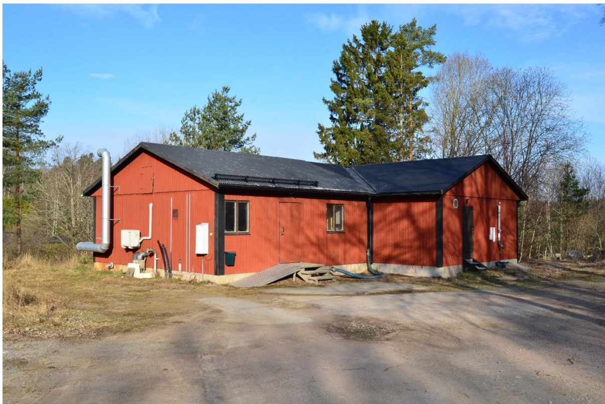
Figur 3. Flintavik reningsverk. Foto: Michael Kämpenber.
