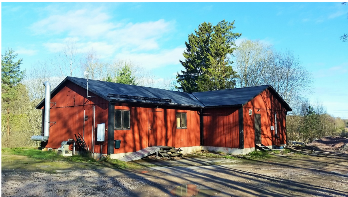
Figur 2. Flintavik avloppsreningsverk. Foto: Michael Kämpenber.
